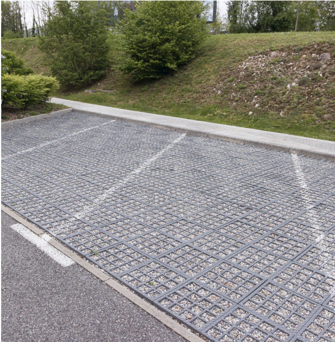
Illustration 19 : Système de sol drainant sur des places de parking. Ce système de drainage permet l'infiltration des eaux pluviales à leur point de chute, sans ruissellement. Cela fait partie de la désimperméabilisation des sols. La technique consiste à supprimer les matériaux de recouvrement imperméable d'un sol ou remplacement de ce dernier par un autre matériau, perméable.
